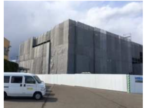
建設中の新建屋 (2017/3/24)
