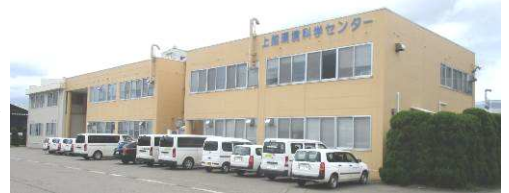
旧社屋（A棟・B棟）
