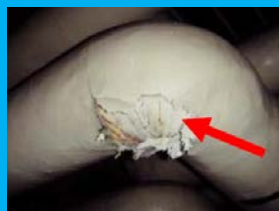
石綿含有断熱材、保温材、耐火被覆材 (レベル2)
